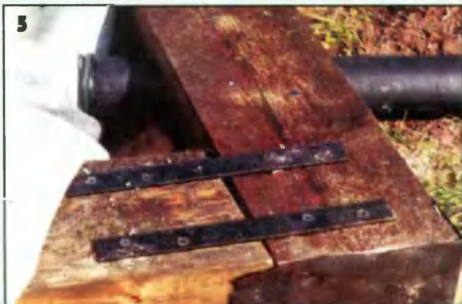
5 Соединение брусев каркаса и размещение переливной трубы.
