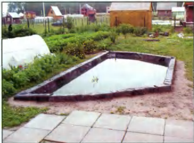
Берега пруда с гидроизолирующим покрытием.
