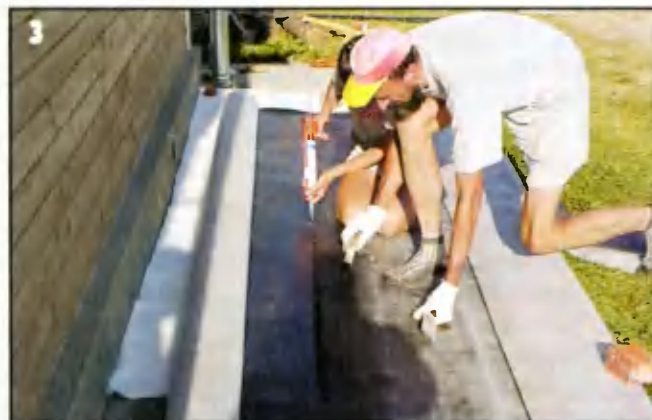
3 Завершающая операция при склейке полотнищ — обработка швов герметиком.
