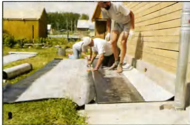
2 Зачистка мест склейки полотнищ и их обезжиривание — необходимый этап создания покрытия, не пропускающего воду.
