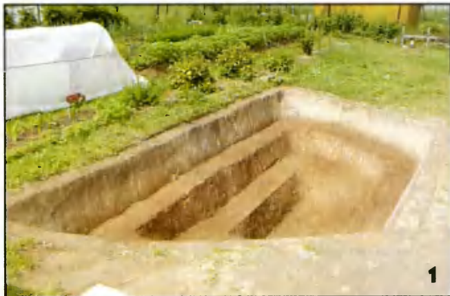
1 Котлован, вырытый по проекту и подготовленный для размещения гидроизолирующего покрытия пруда.
