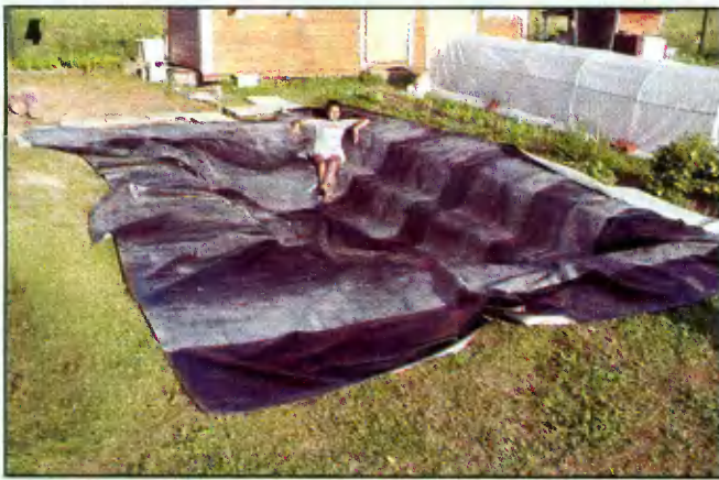
Завершение укладки покрытия вдоль южного берега пруда.
